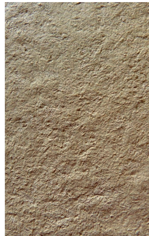
Torchis et chaux chanvre banché
