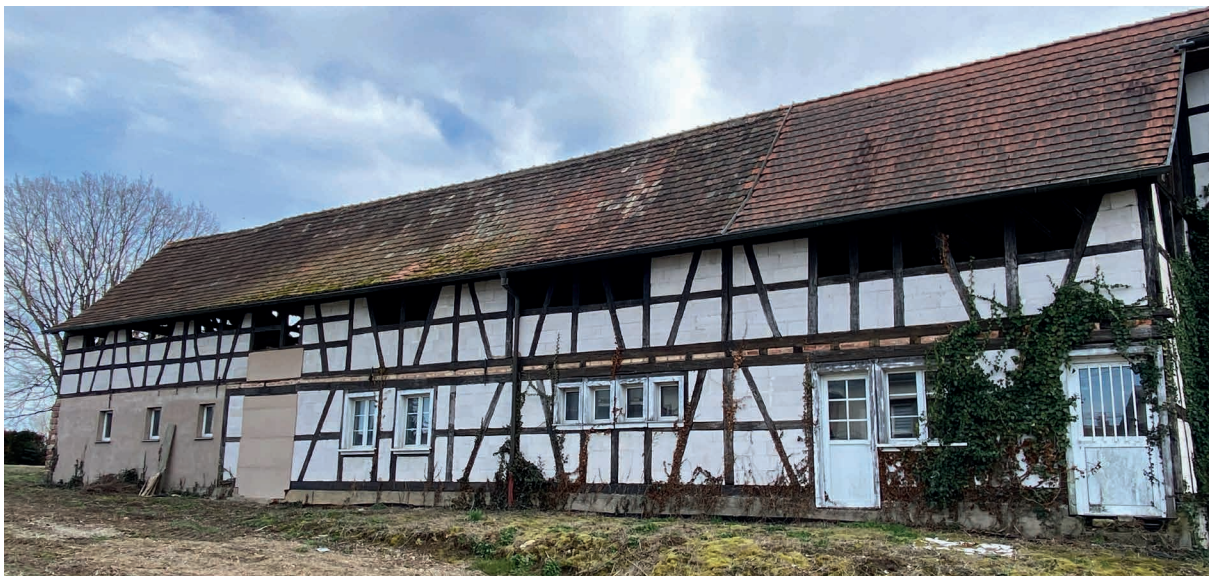
Façade Nord vue du trottoir de la rue principale
