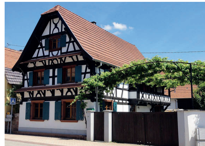
Corps de ferme du 50 rue Principale
