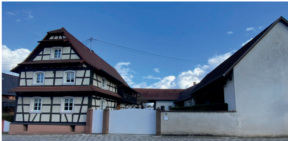
Corps de ferme du 38 rue Principale
