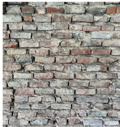
Détails du mur de brique
