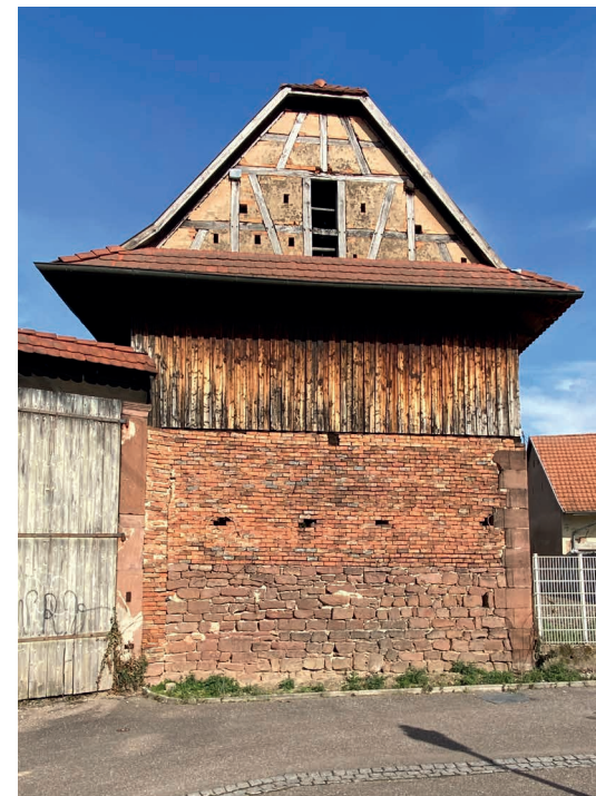
Façade Ouest vue du parking
