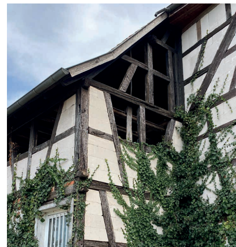
Façade Ouest en lien avec le logis
