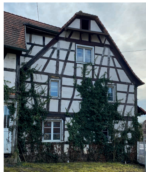
Façade Nord vue de la rue principale
