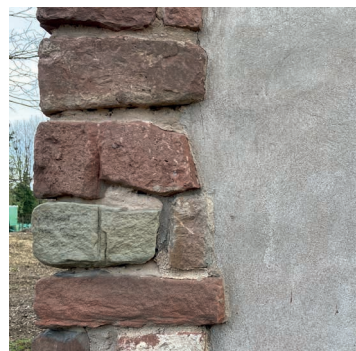
Détails de la chaîne d'angle et du crépi de la façade Nord
