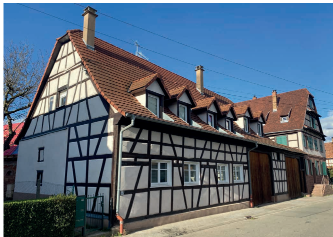
Corps de ferme du 6 rue Weitbruche
