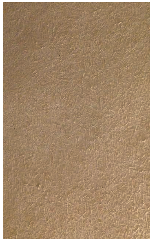
Enduit à la chaux
